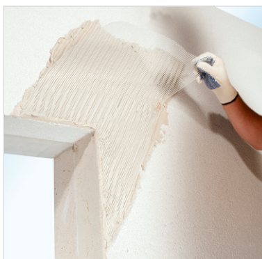
Aplikácia diagonálnej výstuže
