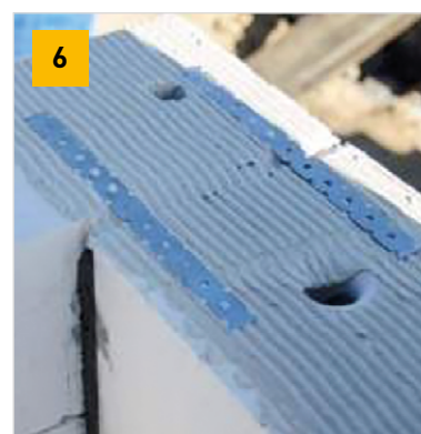
Spojenie nosných stien spojkami muriva
