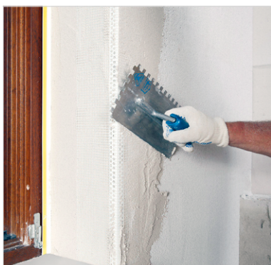
Inštalácia rohového profilu
