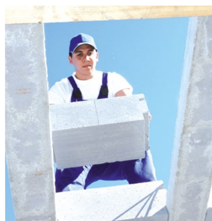
Ukladanie stropných vložiek
