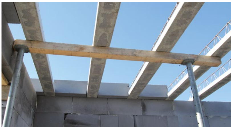
Podopretie stropných nosníkov
