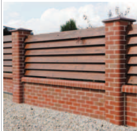
Použitie zaoblených tehál Terca Klinker na stĺpiky a ukončenie podmurovky plotu
