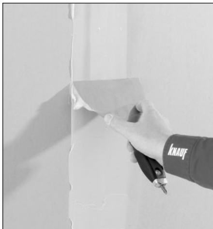
1. Pracovný krok - Safeboard-Spachtel
