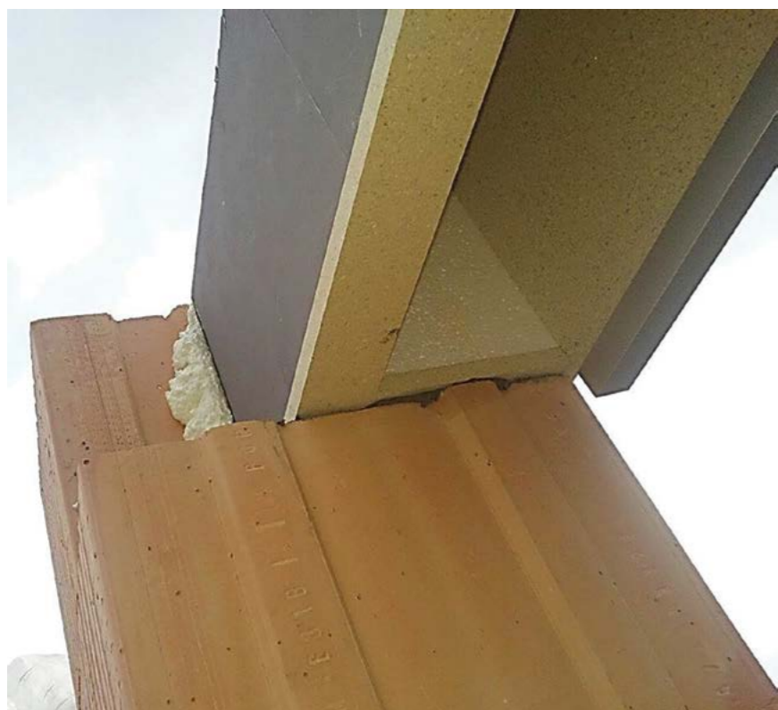
Pohľad z interiérovej strany na osadenú schránku Vario UNI zafixovanú montážnou penou
